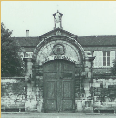
Ancien portail de l'hôpital Condé avant sa démolition © Fondation Condé.
