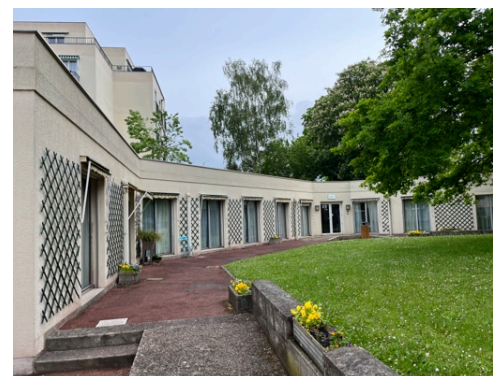
Bâtiment pouvant faire l'objet d'une surélévation
