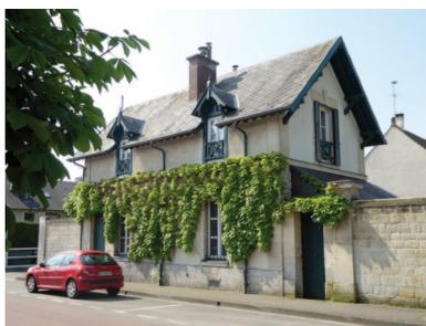
L'ardoise, la tuile mécanique, le zinc, le moellon enduit, la pierre de taille, la brique argile, les faux pans de bois, le bois, le métal, sont les matériaux de construction traditionnels des bâtiments des écuries.
