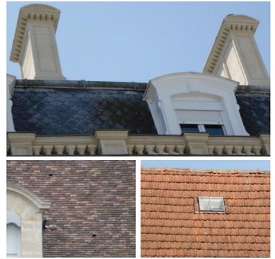
Les couvertures traditionnelles sont en tuile plate de petit moule (60 à 80 au m<sup>2</sup>) ou en ardoise avec le développement des toits à la « Mansart ». La tuile mécanique est très présente aussi sur les architectures des villas et maisons XIX<sup>e</sup>. Les souches de cheminées sont en pierre et/ou en brique. Les gouttières et descentes d'eau pluviale sont en zinc, rarement en cuivre.
