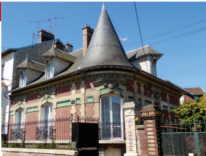
Les ouvertures, ordonnancées, sont de dimensions et de formes variées : baie cintrée, oriel, porte-fenêtre à plusieurs vantaux avec balcon, oeil-de-bœuf, lucarne, capucine, rampante, jacobine, normande...
