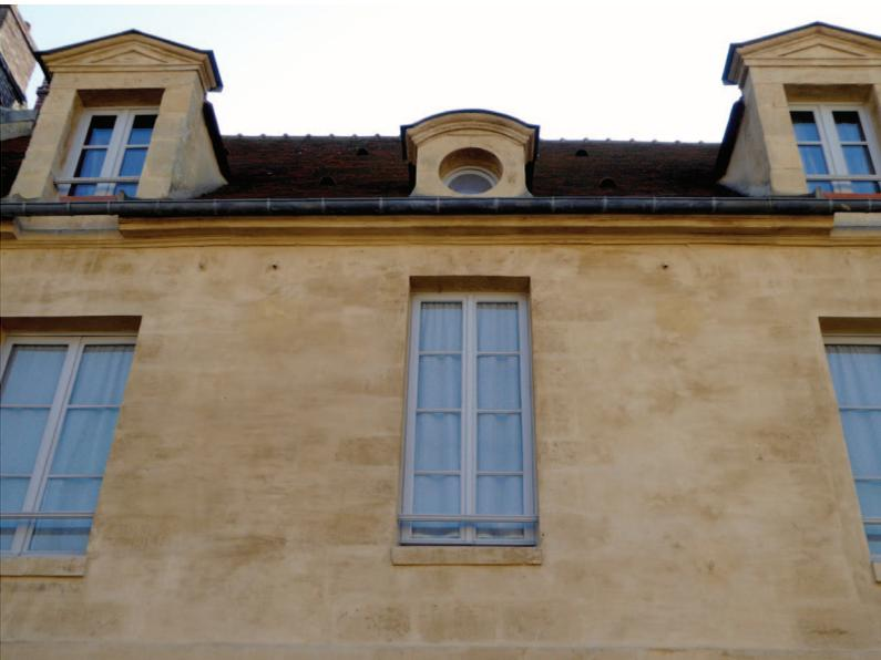
Les menuiseries sont généralement composées de deux vantaux ouvrant à la française (vers l'intérieur de l'habitation), eux-mêmes divisés, traditionnellement en trois carreaux. Sur les grandes fenêtres des maisons chantilliennes, les divisions à quatre carreaux sont fréquemment utilisées pour harmoniser la composition élancée des croisées. Les menuiseries les plus anciennes sont à petits carreaux. Sur certains bâtiments 1870/1930, elles sont diversifiées (en forme, dimension, profil...).
