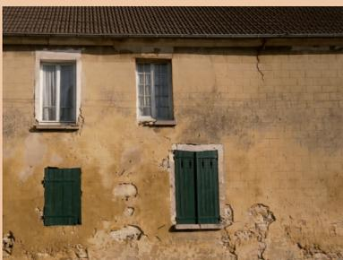
Si des fissures apparaissent (murs, planchers, charpente ...), il faut en rechercher la cause : dilatation des matériaux, désordres d'ordre structurel, mouvement de sol, structure trop faible. Il peut être utile de faire une étude de sol si besoin et demander conseil à un ingénieur structure aussi bien pour les parties maçonnées que pour les pièces de charpente en bois.
