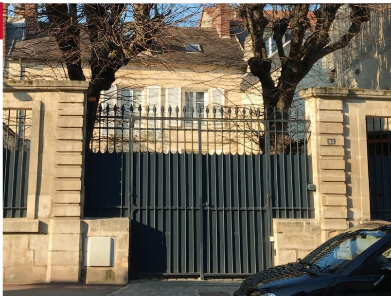
Certains ouvrages de clôtures sont très soignés : piles et faîtes de mur protégés par un couronnement en pierre moulurée pour rejeter les eaux de pluie, mur bahut surmonté de grille en ferronnerie ouvragée.
