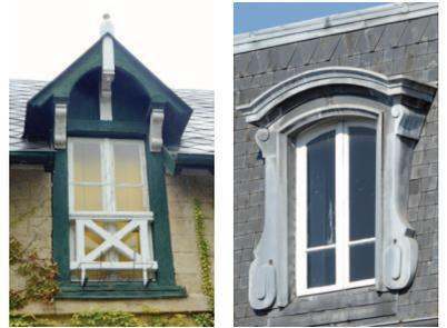
Les lucarnes sont en maçonnerie ou charpentées, recouvertes d'ardoise, de tuile, de zinc ou de plomb.
