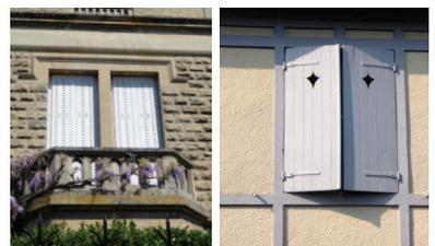
Des feuillures permettent d'insérer les volets dans le tableau des fenêtres afin d'atténuer la prise au vent. Certaines portes comportent deux vantaux. Les dimensions varient entre 1m70 et 2m15 de hauteur, et entre 80 cm et 1m de largeur. Les portes des maisons fin XIX<sup>e</sup> sont surmontées d'une marquise, d'un auvent... Des ferronneries particulièrement ouvragées protègent les parties vitrées des portes et des impostes.
