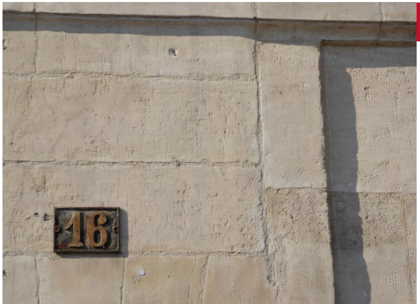
Les murs en pierre de taille des façades, particulièrement rue du Connétable, témoignent d'un appareillage soigné avec des joints fins arasés au nu des blocs.
