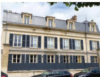
L'ardoise, le zinc, la pierre de taille, le moellon équarri ou bosselé, plus rarement la brique, le métal, le bois sont les matériaux de constructions traditionnels de ces hôtels particuliers. Les nombreuses et riches modénatures protègent les éléments de structure de la construction.
