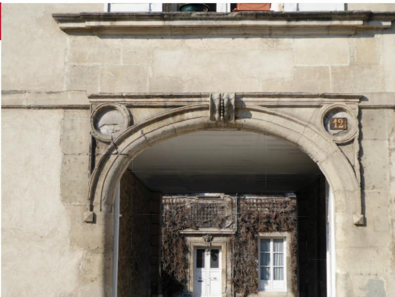
Les ouvertures dans les façades sont des facteurs de fragilité. Elles font l'objet de nombreux détails soignés : proportion, matériau, finition, appareillage...
