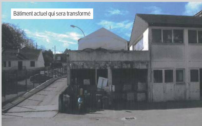
Extension d'ateliers des services techniques
